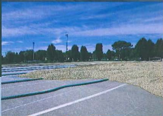
POSA GHIAIA E TUBAZIONI
