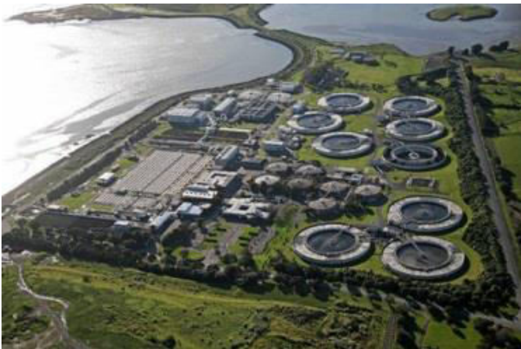
In figura: un esempio di impianto per il trattamento acque.
